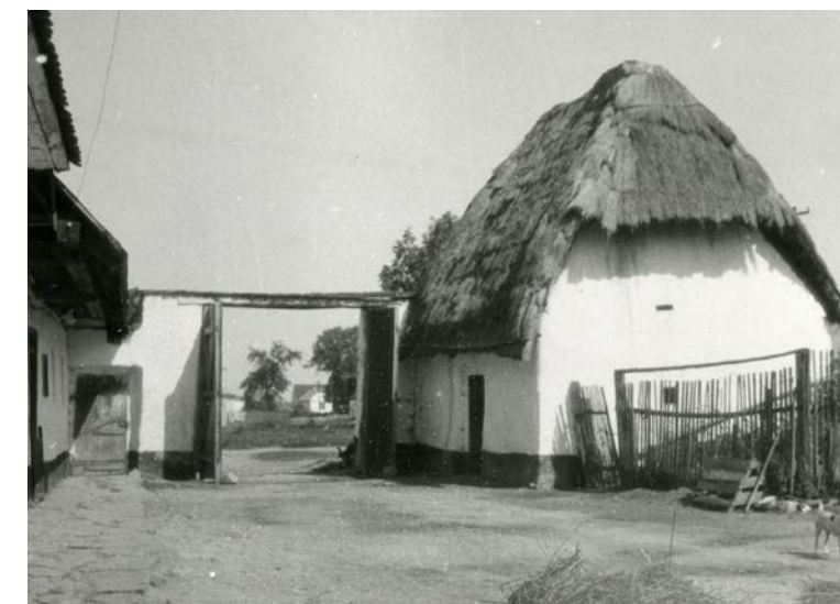
OBR. 12 – Fotografická dokumentace zaniklé sýpky s roubenou klenbou s lepenec­em pod doškovou střechou, se stěnami „v kožichu“. Hlavatce č.p. 10, o. České Budějovice. Autor Antonín Vodsedálek, 1943, rozm. 110 × 85 mm, EÚ AV ČR, fond Hlavní katalog, inv. č. 010321.
