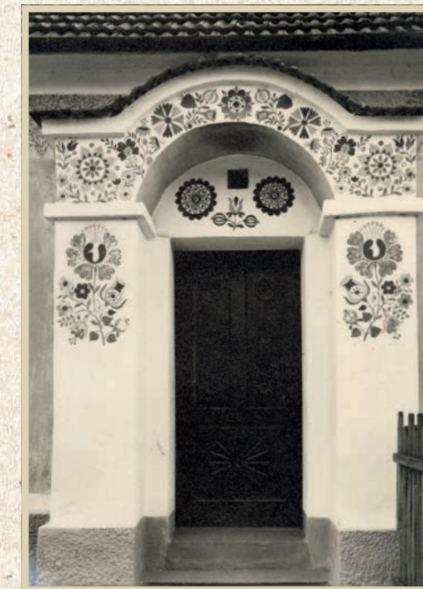
Foto E. Málek, 1924, ANM, i. č. OAE_17852 | Photo by E. Málek 1924, ANM, i. No. OAE_17852
