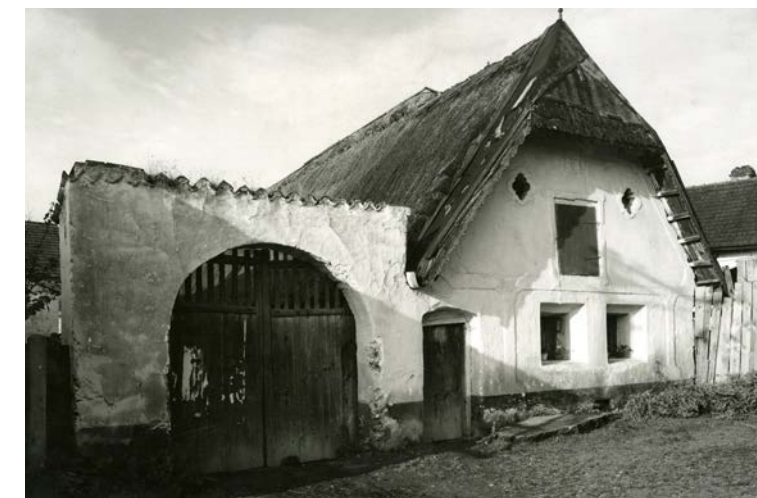
OBR. 17 – Menší usedlost datovaná 1834, s dosud doškovou střechou a se štukovou výzdobou štítu, Sedlec č.p. 24, o. České Budějovice. Autoři Miroslav a Věra Chalupníčková, 1940, rozm. 180 × 120 mm, EÚ AV ČR, fond Studijní archiv, inv. č. 00460STA.
